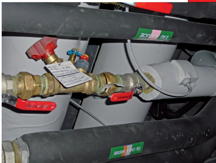
Photo 2 - Vanne d'équilibrage et sonde de température
